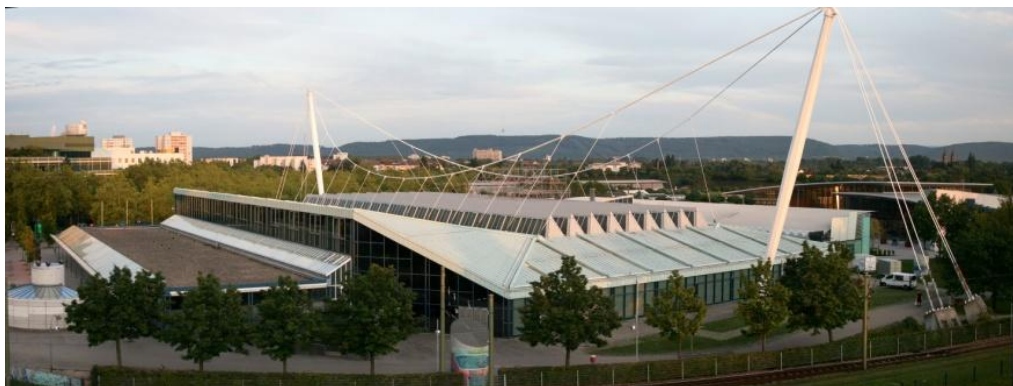
Die Europahalle mit frei hängendem Dach an 2 Pfeilern und 2 Tragseilen
